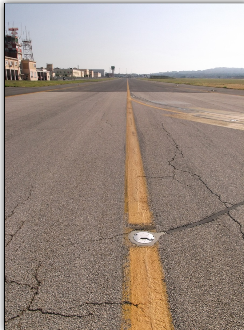
Ammaloramento della pavimentazione esistente in corrispondenza tratto taxiway "TS" fronte raccordo "D"
